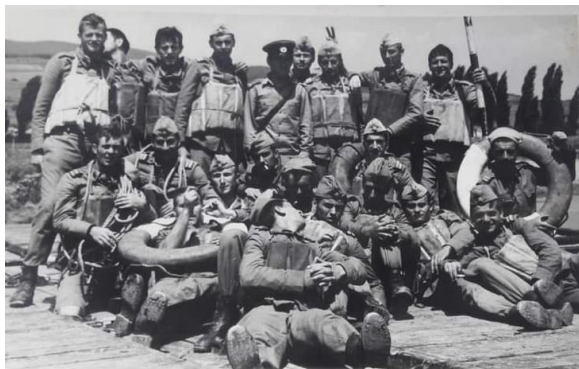
La instrucție pe pontoane la râul Mureș
