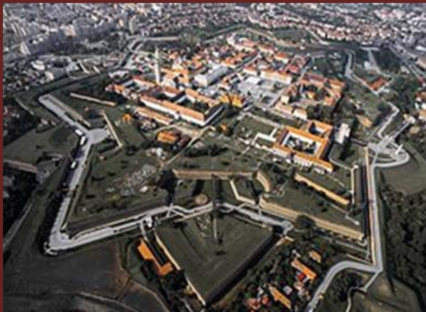
Imaginea de azi, a cetății Alba Carolina, din Alba Iulia, înființată de austrieci la 1714 după un model de construcție de tip Vauban, cu ziduri groase și cu un adânc și larg șanț de apărare Imagine luată de pe en.wikipedia.org
