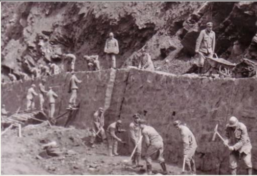
Executarea zidurilor de sprijin după derocarea versanților, rănguirea lor și colectarea, dirijarea infiltrărilor pânzei de apă freatică.
