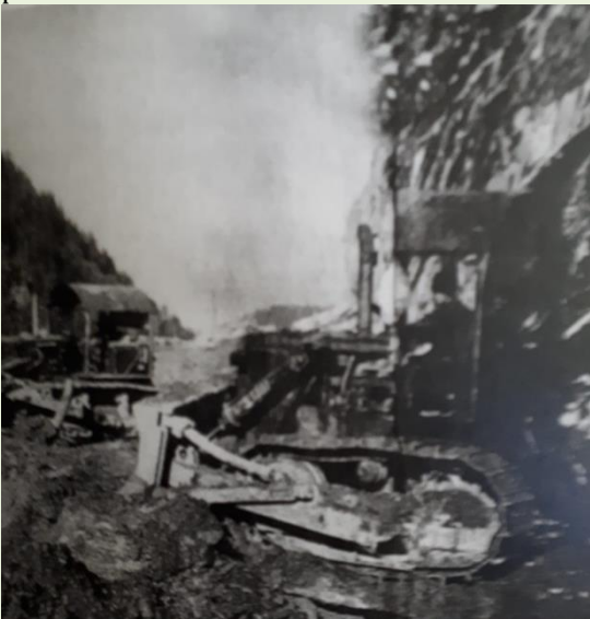
Buldozere S1500 și S1300 lucrând la realizarea stratului de rezistență a drumului în zona porților "Întâlnirii" și a "Geniștilor."
