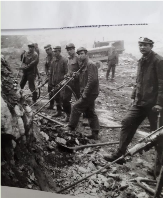
Executarea găurilor de mină la bază versantului.
