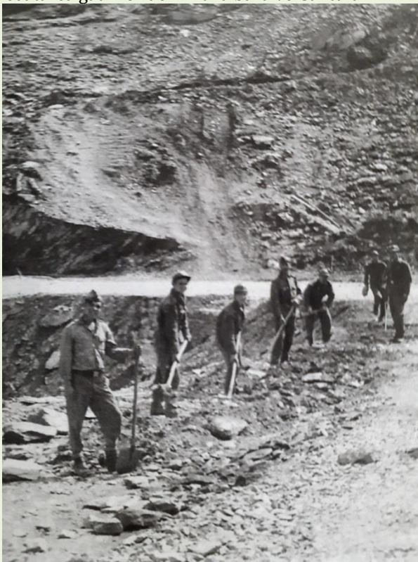
Militari geniști efectuând finalizarea platformei drumului.
