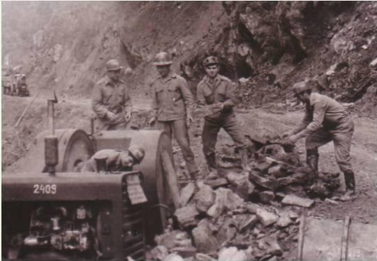
Pregatirea blocurilor de piatră pentru înzidire la zidurile de sprijin, dar și concasarea celor care nu puteau fi fasonate.
