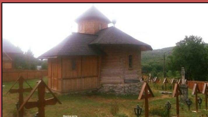
Agafton- Biserica Sf. Voievozi, renovată și cimitirul, 2010
