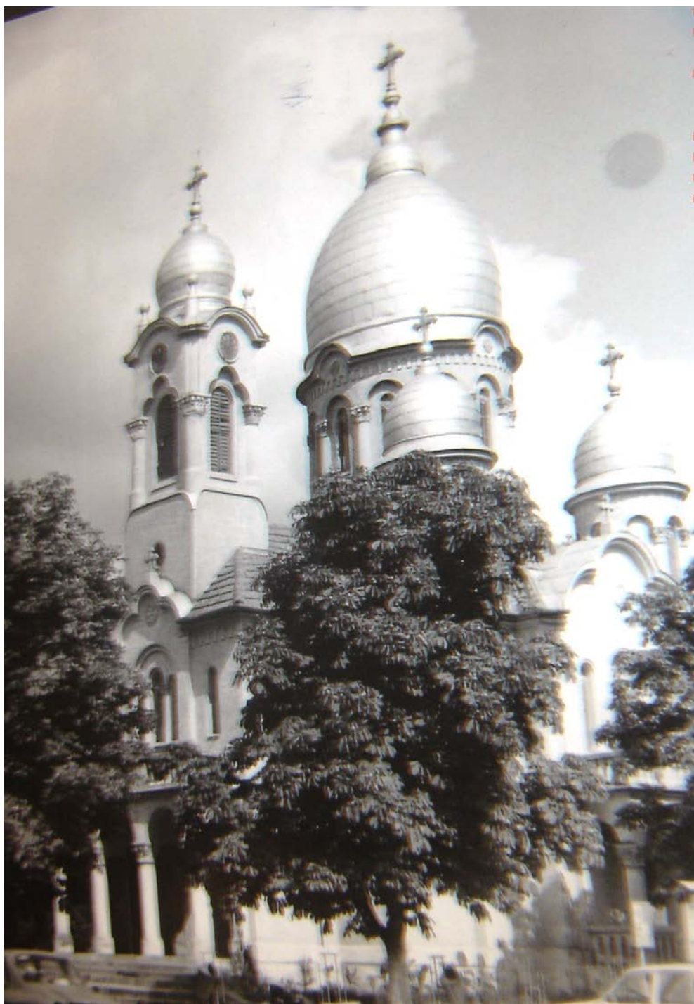
Biserica din Aleșd, construită cu sprijinul armatei ( 1939)
